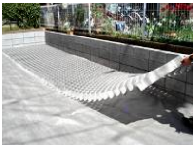
端部を仮留めし、 グラウンドグリッドを拡張する
