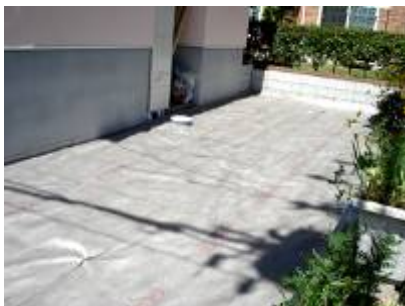
下地としてグリーンビスタ®プロ 砂利下シートを敷設する
