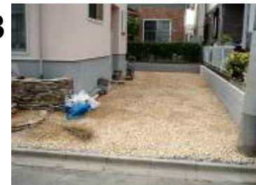
要望に応じて、化粧砂利を 表面に敷きこみ完了 必要により転圧する
