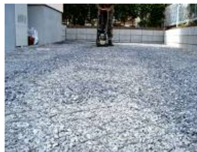
グラウンドグリッド天場まで充填 が完了したらランマーで転圧する
