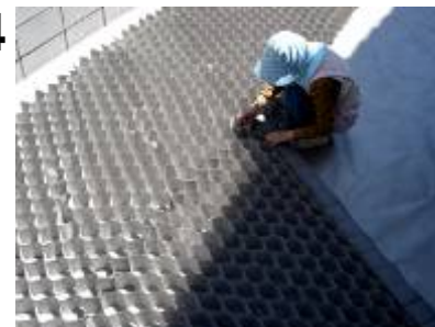
接合部は、ステープルにて仮留め
